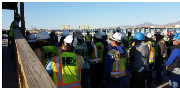
HEI El Paso Plant
